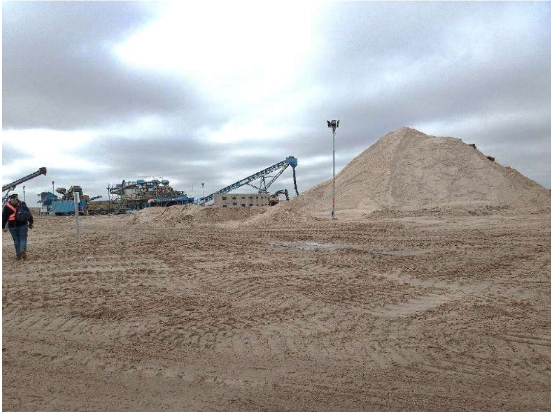
Área de acopio del mineral.
