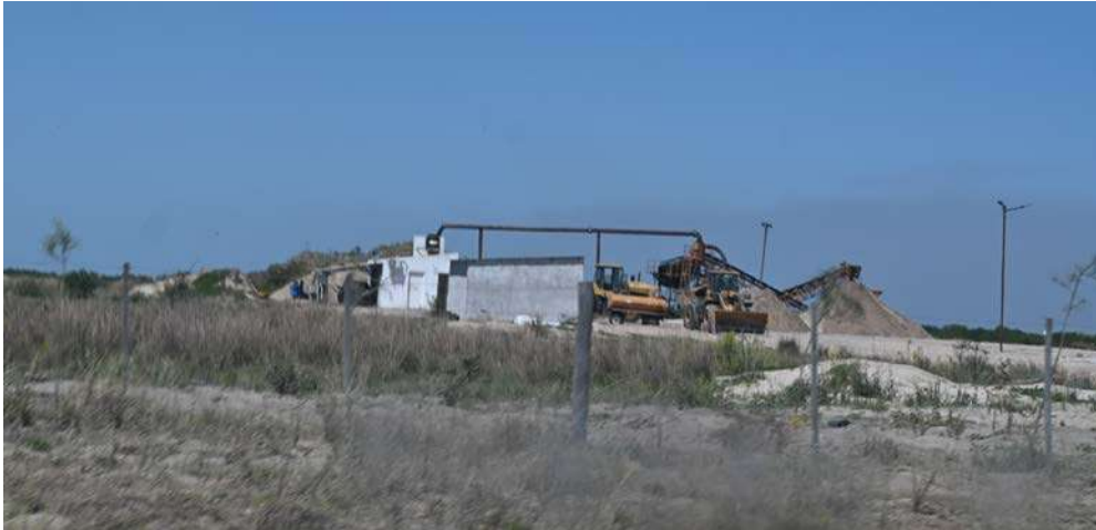
Vista desde la ruta de la planta de lavado El Arenal
