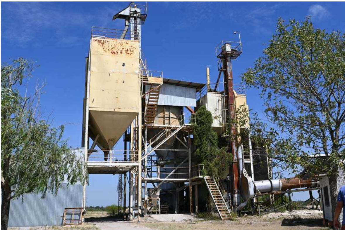
Planta de lavado Las Casuarinas, inactiva.
