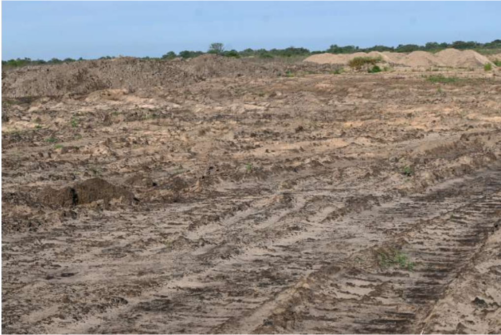
Sector con descarte de suelo depositado recientemente y nivelado. YPF El Mangrullo.
