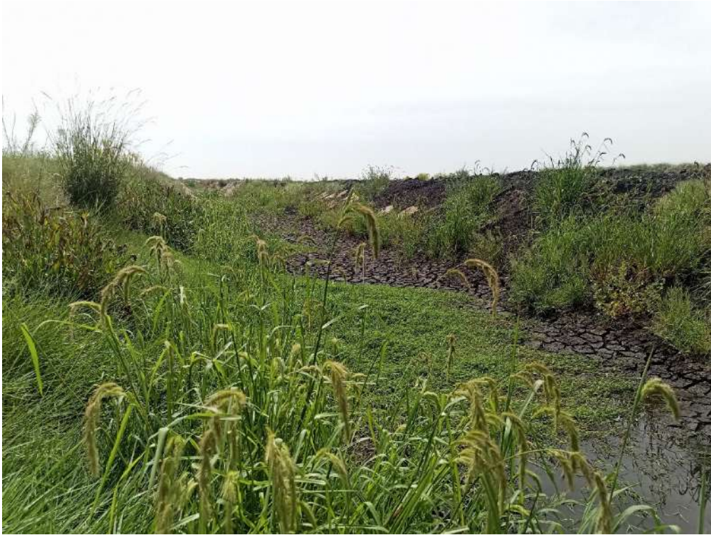
Detalle de la laguna de decantación, sin uso al momento de la visita, que va siendo colonizada por la vegetación.
