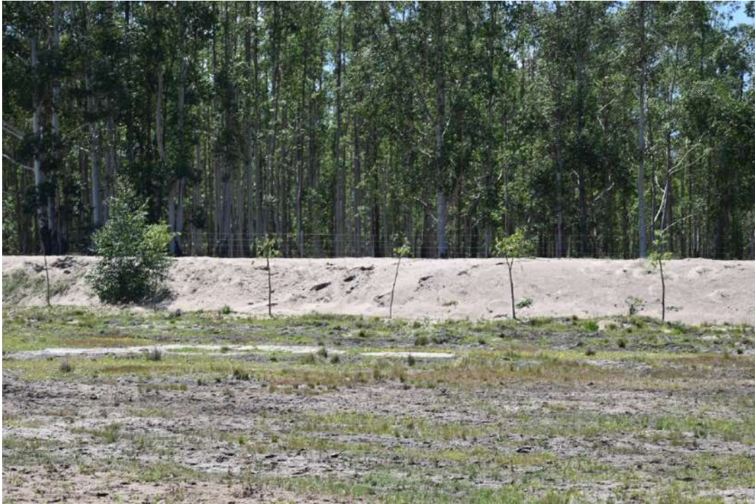
Límite con la forestación vecina. Se observa el talud suavizado y una cortina lateral de sauces implantados. Los sauces son propios de las áreas de recuperación natural del sector ya cerrado de la cava.
