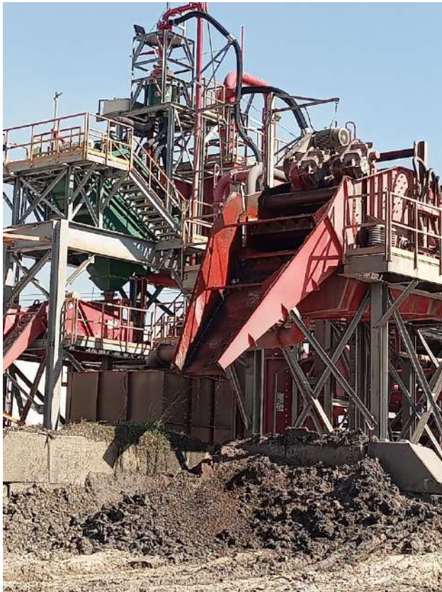
Acumulación de rechazos de planta.
