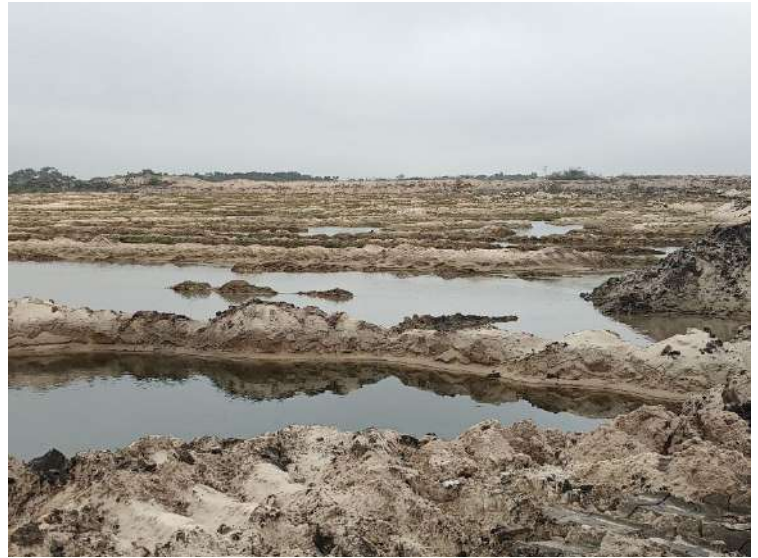
Extracción de arena Frentes de cavas
