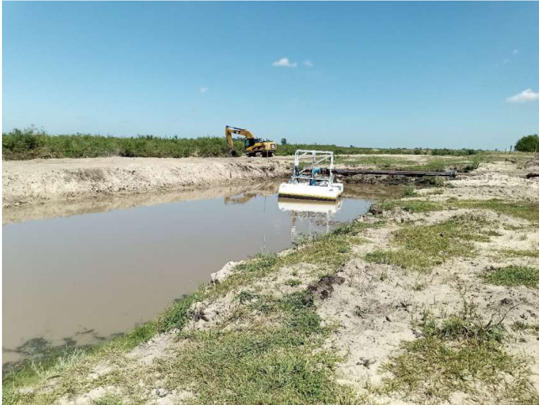
Toma de agua en la pileta de recirculación.
