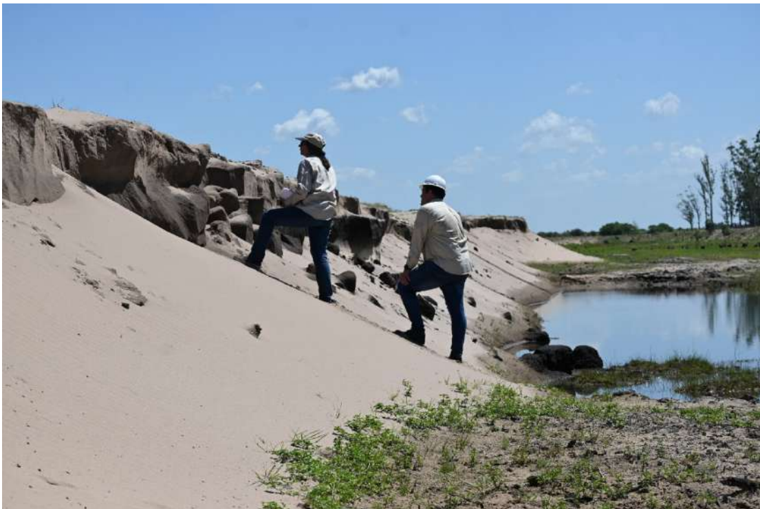
La Dra. Marcchionni y el Ing. Duarte inspeccionado el frente de cantera.
