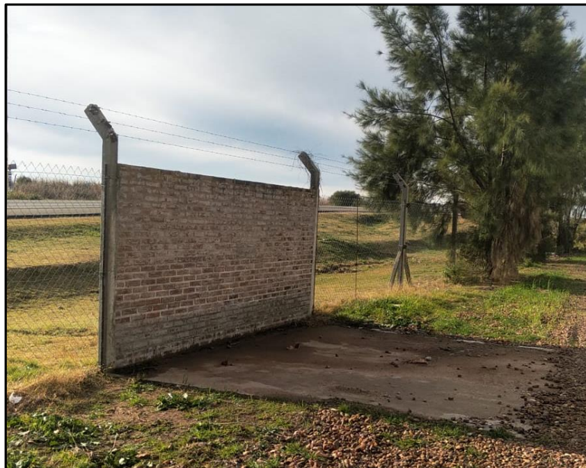
Imagen N°26: Estructura existente para adaptar el depósito de residuos peligrosos
