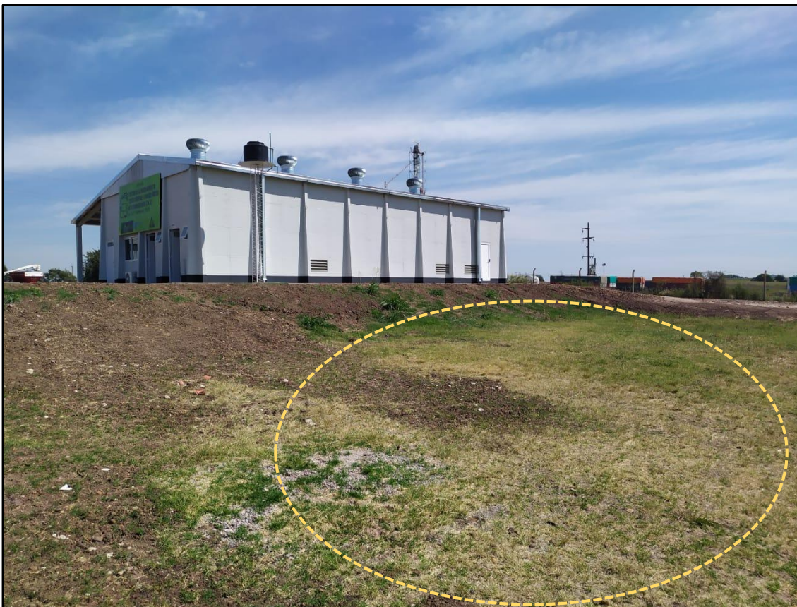
Imagen N° 10: Emplazamiento del CAT. A continuación, sitio de localización del proyecto, sin intervención
