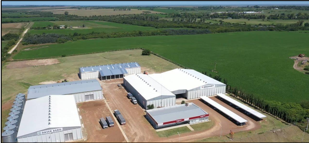
Imagen N°9: Instalaciones DASER AGRO SA, sin intervención del proyecto
