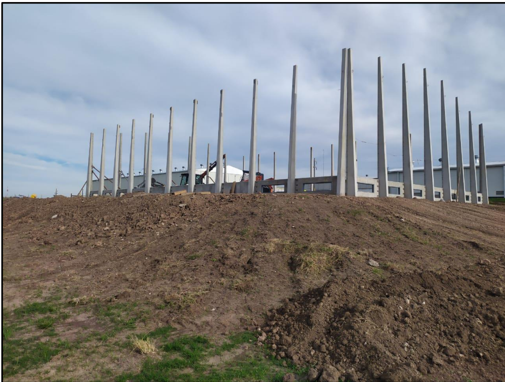
Imagen N°12: Emplazamiento de la obra: movimiento de suelo y base de la estructura pre moldeadas
