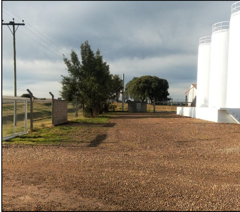
Imagen N°25: Vista de la ubicación del depósito de residuos peligrosos
