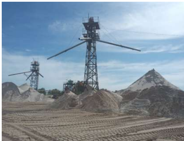
Figura V 69. Vista general de la Planta El Arenal
