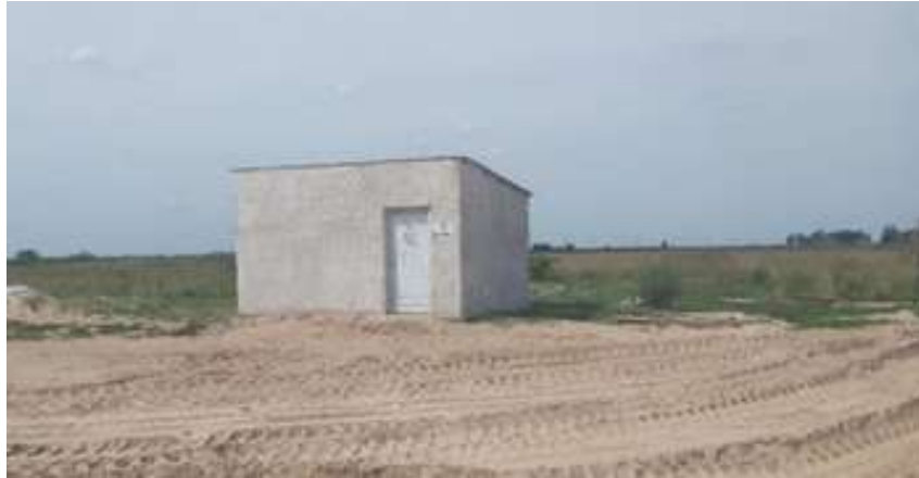
Figura V 52. Depósito de residuos peligrosos.
