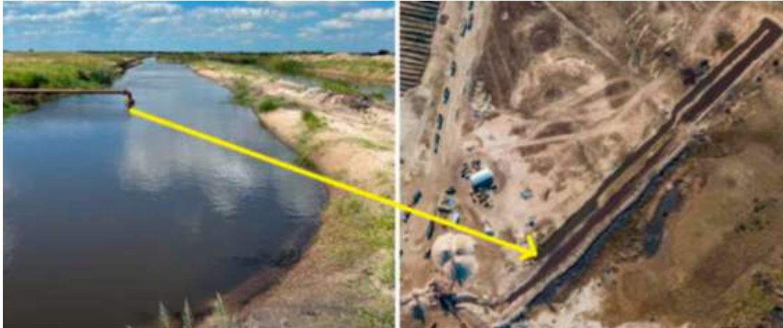
Figura V 21. Circuito de recupero de agua: Sistema de recirculación y bomba que reintroduce el agua en la planta. En líneas amarillas el sentido de la circulación.
