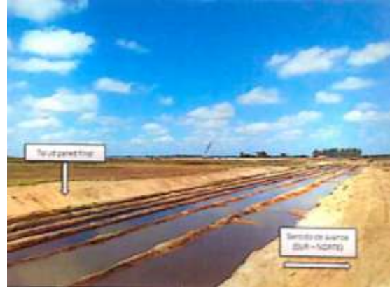
Figura V 7. Sentido de la explotación de S a N dejando una cara libre de avance (N) y una pared final perfilada (S).
