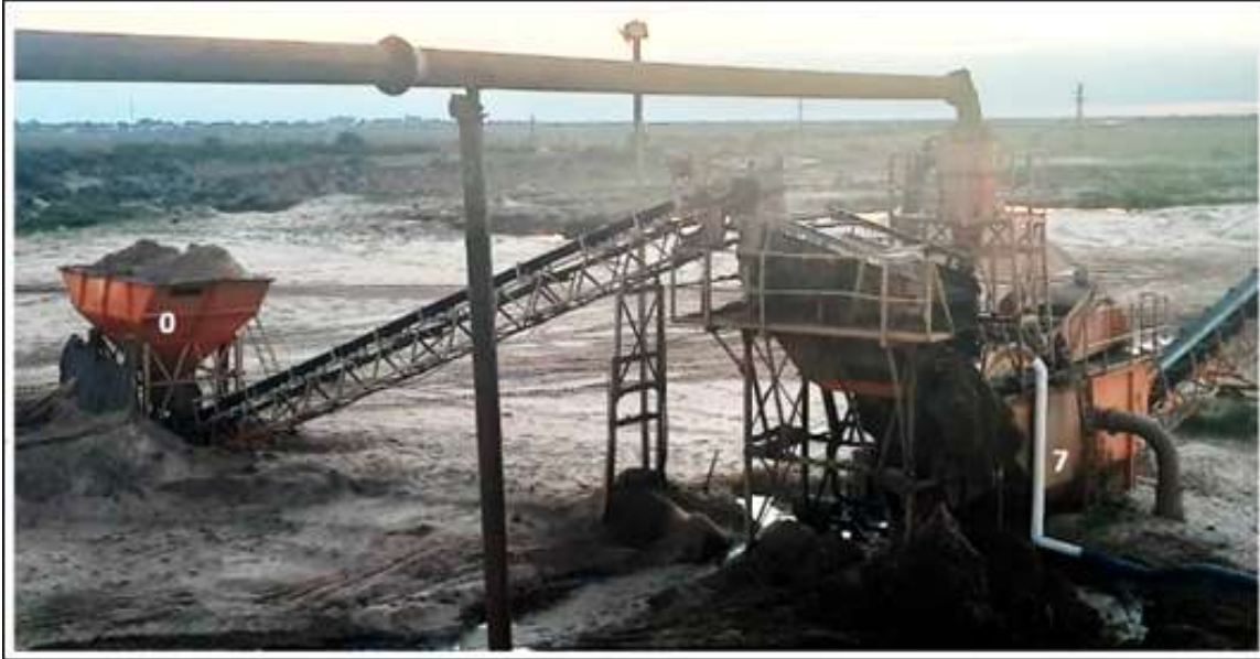
Figura V 45. Imagen de la planta actual; 0- Tolva de ingreso, 7- Ingreso de agua desde el sistema de recirculación.
