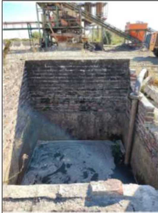
Figura V 76. Cuba de decantación de mampostería.
