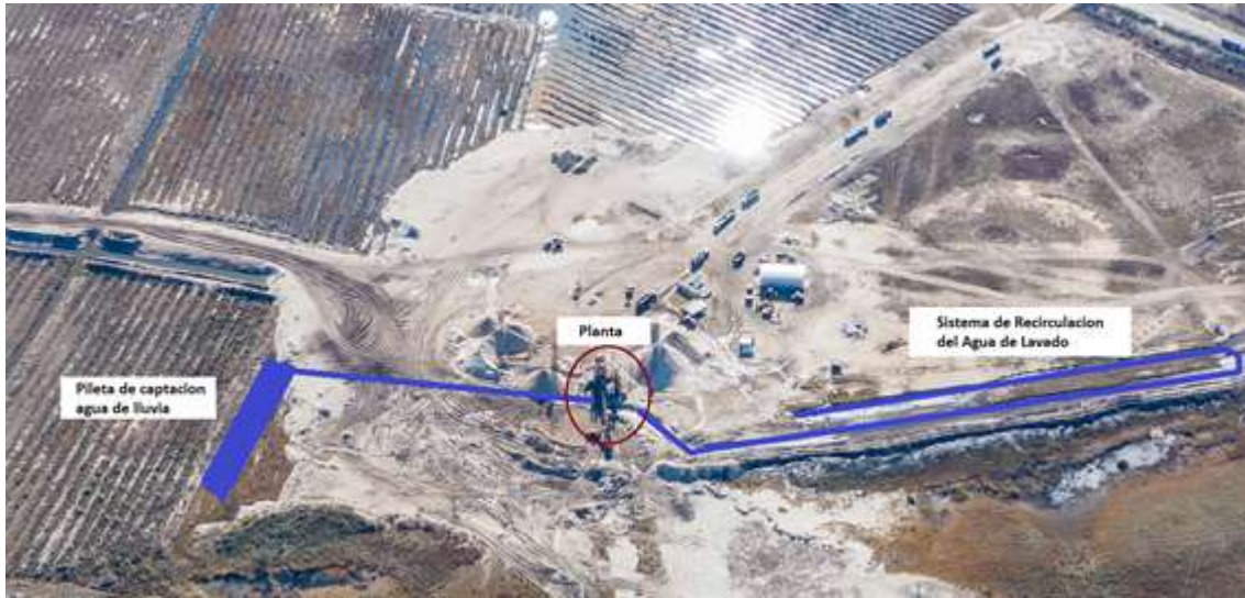
Figura V 22. Sistema de Captación de Agua de Lluvia
