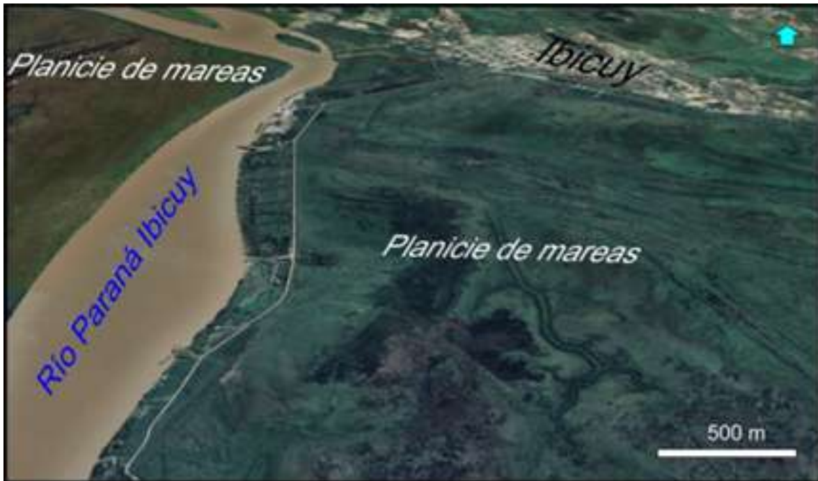
Figura IV 5. Vista aérea de la Planicie de mareas ubicada al sur de la ciudad de Ibicuy. Imagen obtenida de Google Earth.
