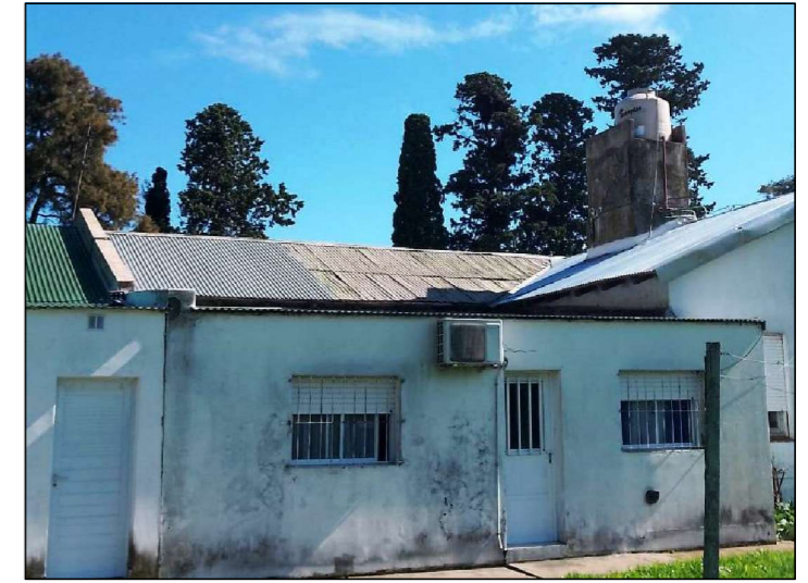
VISTA DE CUBIERTA EN CONTRAFRENTE
