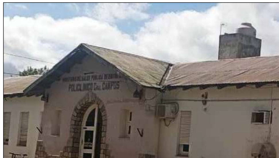
VISTA DE CUBIERTA EN FACHADA
