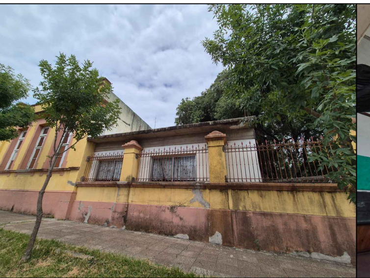
6-Fachada Princ. Norte Aula Expan.
