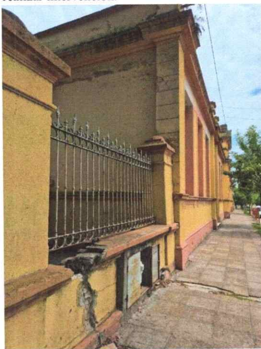
*Otro ángulo de la misma contra fachada, sector crítico de desagües pluvial, necesidad de realizar intervención.
