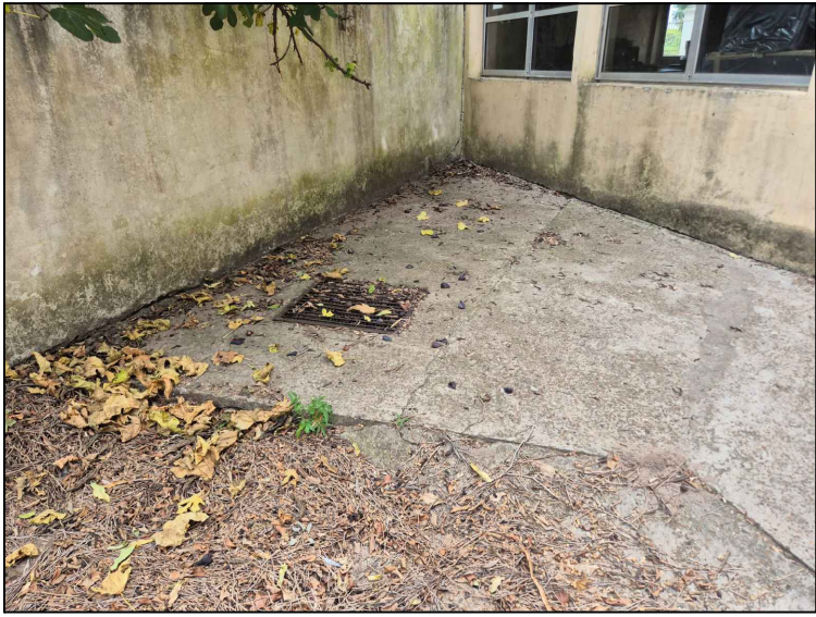
19- Desague Pluvial Existente
