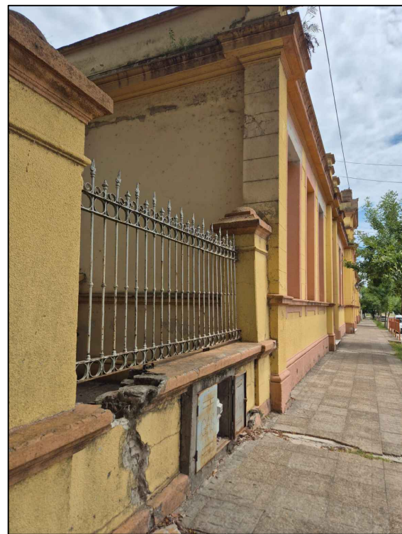
Muro de Fachada
