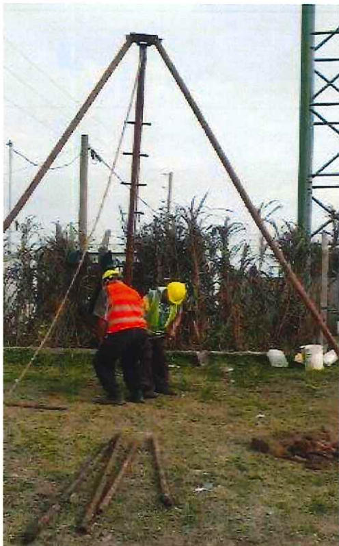
Imagen 02-03: Tareas de Barrenado – C. Avellaneda
