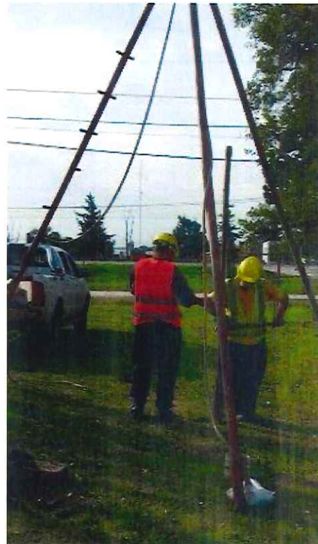
Imagen 03: Ejecución Ensayo -SPT Oro Verde
