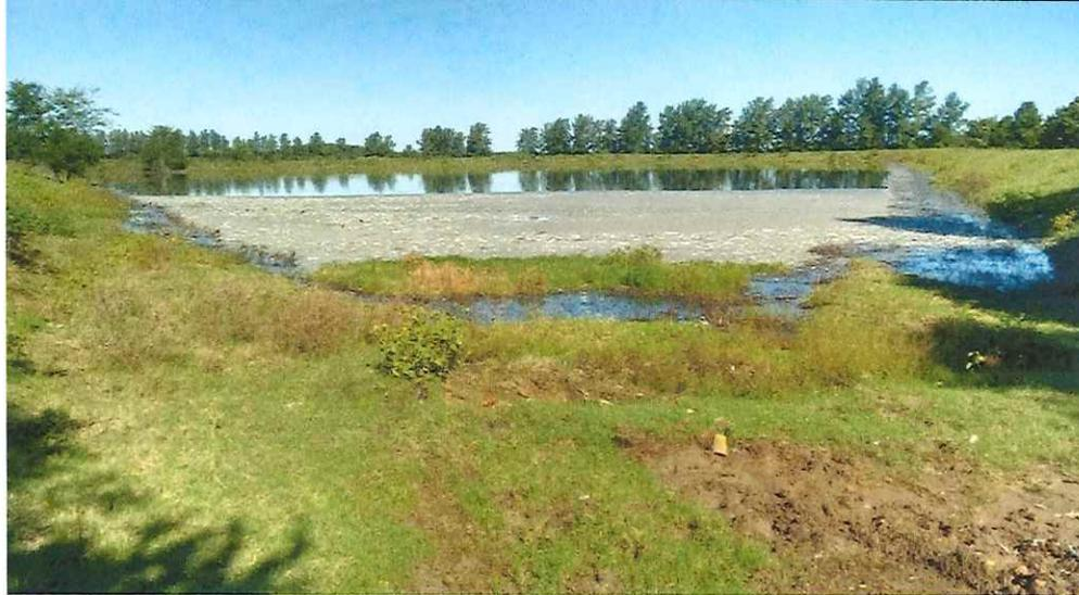
**Imagen 8.** Sólidos en suspensión, sector de descarga de camiones atmosféricos.
