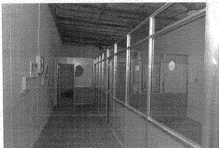
Imágenes de los paneles divisorios de aluminio y vidrio. Se observa la cañería de la instalación eléctrica por fuera de la pared.
