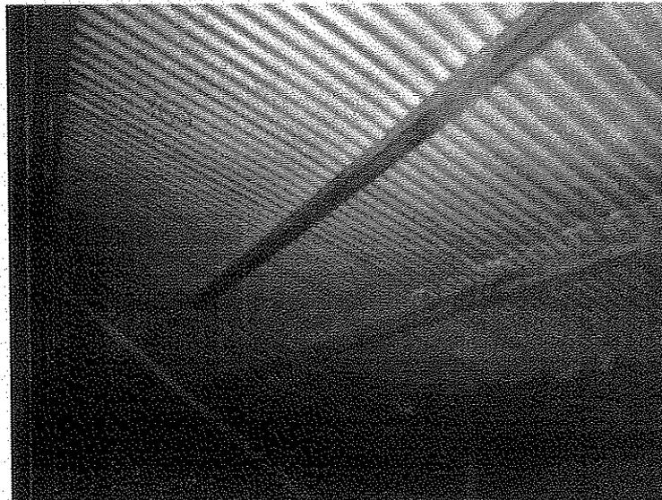
En esta imagen se puede observar el buen estado que se encuentran los clavadores, estructura y chapas desde el interior
