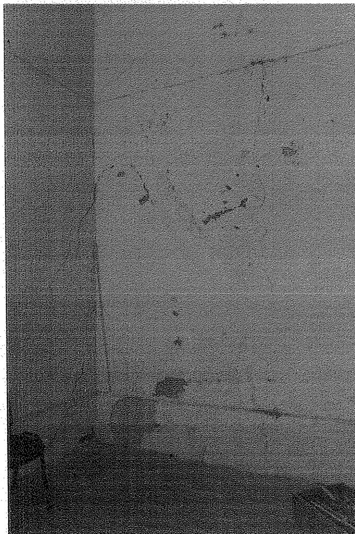
*Pared lateral derecho de escenario donde se puede observar parte de revoque saltado por ingreso de humedad, fisuras en pared por asentamiento*
