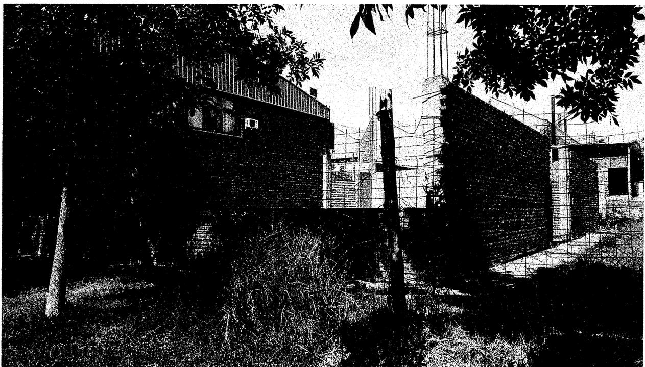
Mampostería Existente construida hasta la altura del encadenado de primer piso.-
