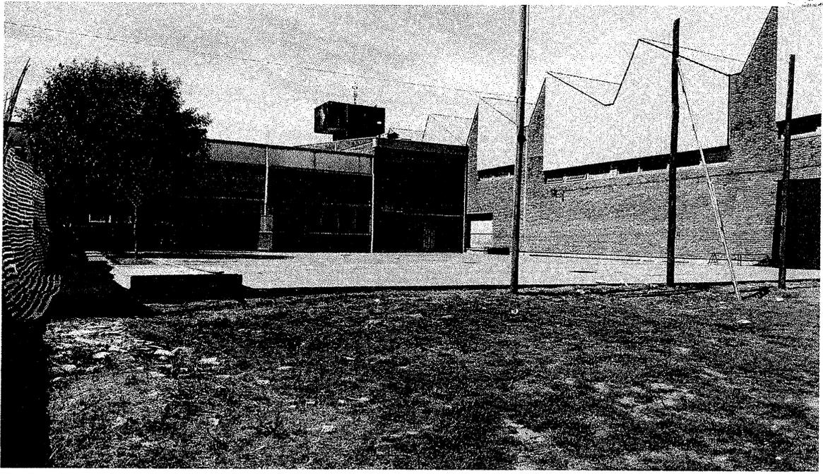
Patio construido en hormigón con malla sima y terminación de baldosas de 0.60mx0.40m.-
