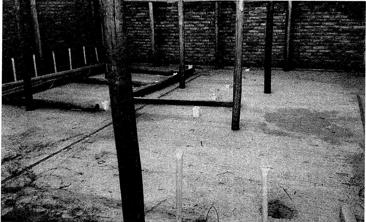
Cañerías de desagües Sanitarios en PVC de  $\varnothing$  110 mm,  $\varnothing$  63mm y  $\varnothing$  40mm, esp. 3,2mm para la construcción de un nuevo grupo sanitario. -
