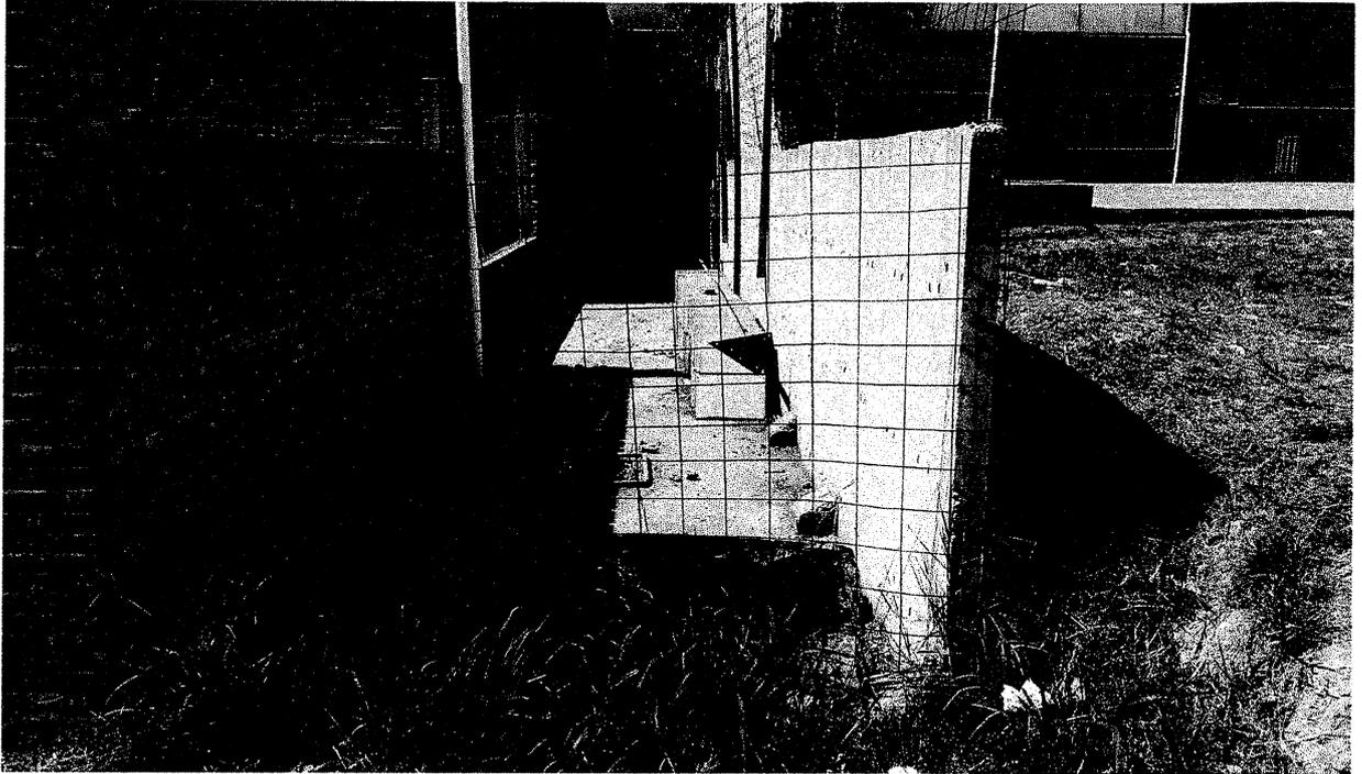
Mampostería de doble muro de ladrillos visto comunes y muro de contención realizado en H° A°
