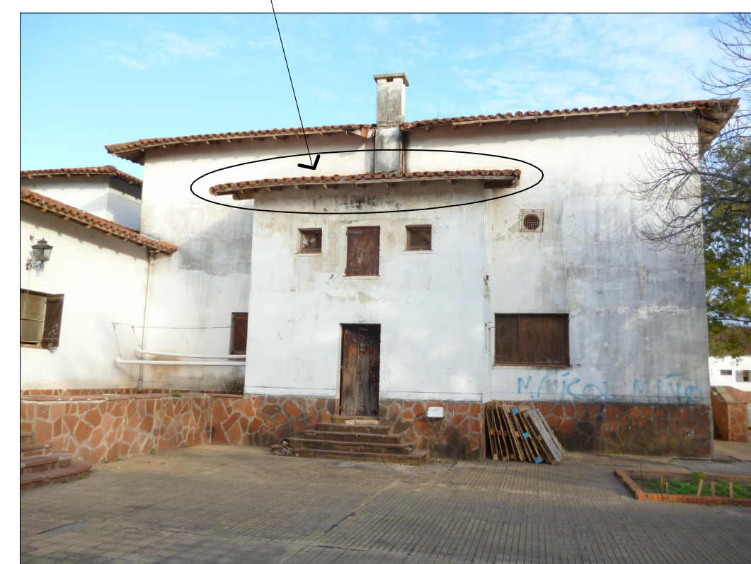
Restauración de cubierta en sala de proyecciones s/c
