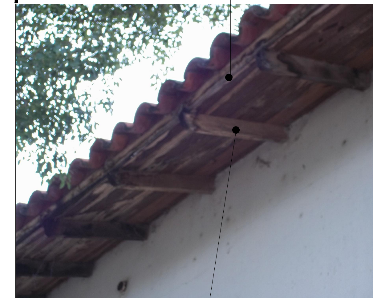
Restauración de cables s/c.
