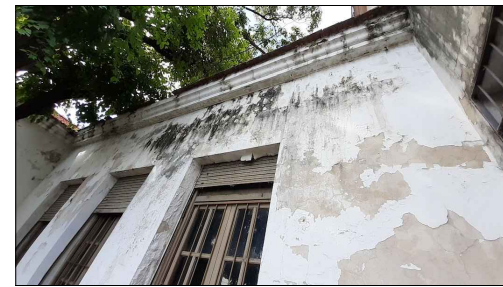
Se procederá completando, reparando y/o ejecución de un nuevo revoque sobre las superficies que se encuentren deterioradas, afectadas por la acción de la humedad. Sellar grietas y fisuras que se encuentren en el soporte con sellador para exterior de 1° calidad para evitar que las mismas se trasladen luego a la pintura.
