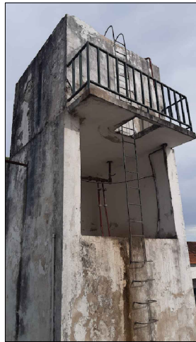
Se contempla una primera aplicación de azotado impermeable y una posterior terminación de revoque exterior completo a la cal terminación al fieltro.
