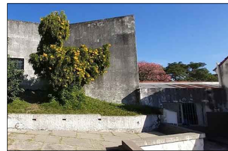
Se realizó un hidrolavado a alta presión de toda la superficie de paredes y veredas perimetrales previo a tratar. Deberá quedar libre de restos de revoque, hongos, y vegetación.
