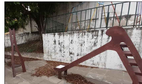
Se procederá completando, reparando y/o ejecución de un nuevo revoque sobre las superficies que se encuentren deterioradas, afectadas por la acción de la humedad. Sellar grietas y fisuras que se encuentren en el soporte con sellador para exterior de 1° calidad para evitar que las mismas se trasladen luego a la pintura.
