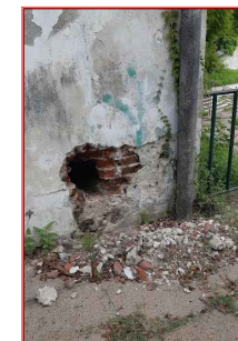
En algunas partes el nivel del deterioro requerirá de una reconstrucción y reemplazo del revoque por uno nuevo. En el resto de la fachada, donde no se justifique la extracción y reemplazo de revoque se cepillará la superficie con cepillo de acero y luego se lijará para remover restos que se encuentren sueltos para su posterior completamiento. Los revoques nuevos no deberán presentar superficies alabeadas ni fuera de plomo, rebabas u otros defectos. Se contempla una primera aplicación de azotado impermeable y una posterior terminación de revoque exterior completo a la cal terminación al fieltro.
