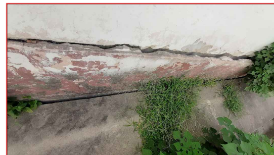
En algunas partes el nivel del deterioro requerirá de una reconstrucción y reemplazo del revoque por uno nuevo. En el resto de la fachada, donde no se justifique la extracción y reemplazo de revoque se cepillará la superficie con cepillo de acero y luego se lijará para remover restos que se encuentren sueltos para su posterior completamiento. Los revoques nuevos no deberán presentar superficies alabeadas ni fuera de plomo, rebabas u otros defectos. Se contempla una primera aplicación de azotado impermeable y una posterior terminación de revoque exterior completo a la cal terminación al fieltro.
