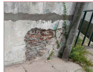
En algunas partes el nivel del deterioro requerirá de una reconstrucción y reemplazo del revoque por uno nuevo. En el resto de la fachada, donde no se justifique la extracción y reemplazo de revoque se cepillará la superficie con cepillo de acero y luego se lijará para remover restos que se encuentren sueltos para su posterior completamiento. Los revoques nuevos no deberán presentar superficies alabeadas ni fuera de plomo, rebabas u otros defectos. Se contempla una primera aplicación de azotado impermeable y una posterior terminación de revoque exterior completo a la cal terminación al fieltro.
