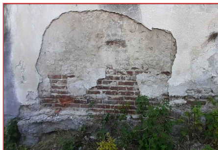
En algunas partes el nivel del deterioro requerirá de una reconstrucción y reemplazo del revoque por uno nuevo. En el resto de la fachada, donde no se justifique la extracción y reemplazo de revoque se cepillará la superficie con cepillo de acero y luego se lijará para remover restos que se encuentren sueltos para su posterior completamiento. Los revoques nuevos no deberán presentar superficies alabeadas ni fuera de plomo, rebabas u otros defectos. Se contempla una primera aplicación de azotado impermeable y una posterior terminación de revoque exterior completo a la cal terminación al fieltro.
