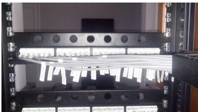
Todos los puestos de trabajo serán etiquetados con indicación de Armario de Comunicaciones, piso de ubicación del mismo, panel de interconexión y número de puerto del cual proviene el cableado, este rótulo deberá ser impreso con fuente n° 24 e instalado en el soporte porta etiquetas que poseen los Face Plate.
