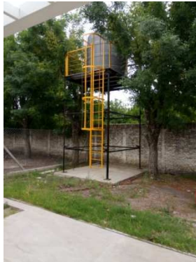
Tanque de Reserva (incluye colector más bombeo)
