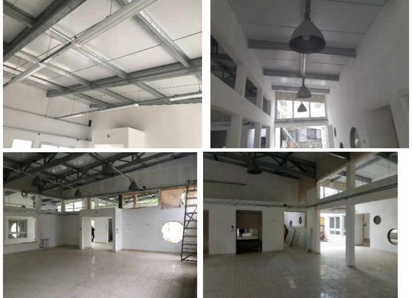
Bocas de Iluminación Interior
