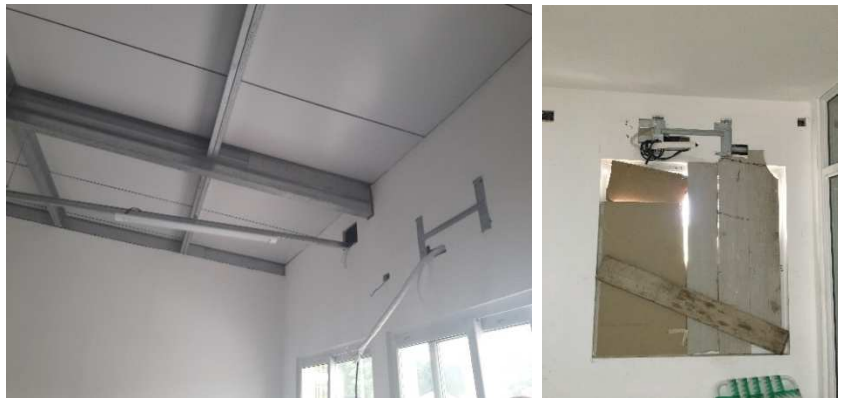
Tomas de Aire Acondicionado
