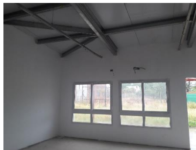
Salas (Colocación Nuevo Piso Vinílico Según Pliego)
