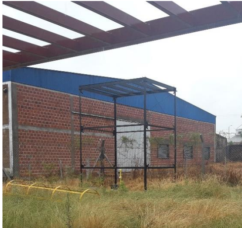
Estructura Metálica en Elevación
