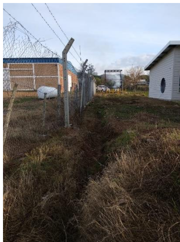
Cerco perimetral con Portón de Acceso
