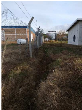
Cerco perimetral con Portón de Acceso
