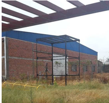
Estructura Metálica en Elevación
