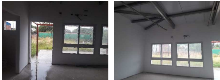
Tomas de Aire Acondicionado
