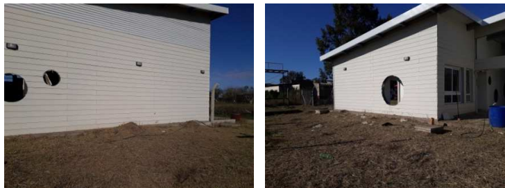
Bocas de Iluminación Exterior
